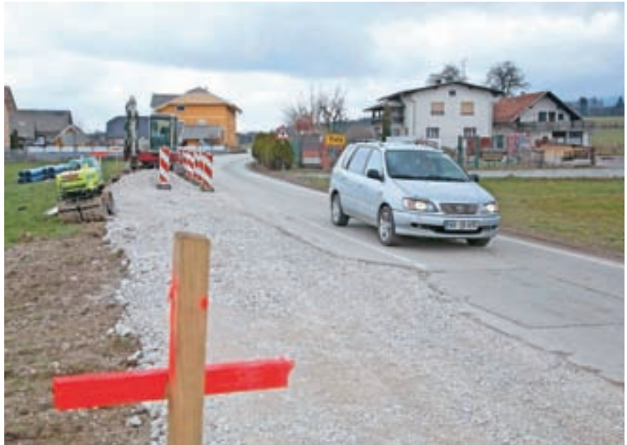
Gradnja krvavškega vodovoda je v polnem teku. / Foto: Gorazd Kavčič
